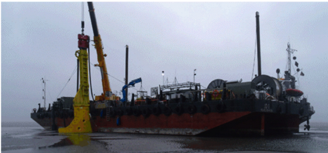
Fotos: Impressionen einer Baustelle zur Kabelverlegung im Wattenmeer
